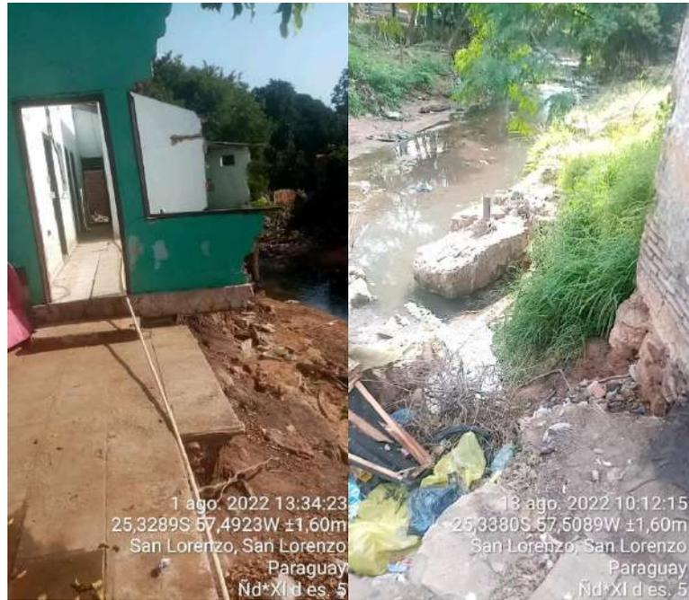
Figura 51. Imágenes de perdidas ocasionadas por desmoronamiento del terreno
